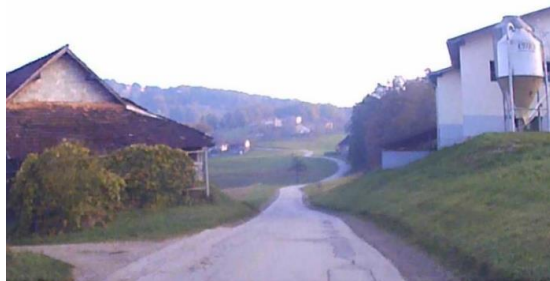
Slika 6-2: Prikaz obstoječega stanja lokalne ceste LC 490 370
