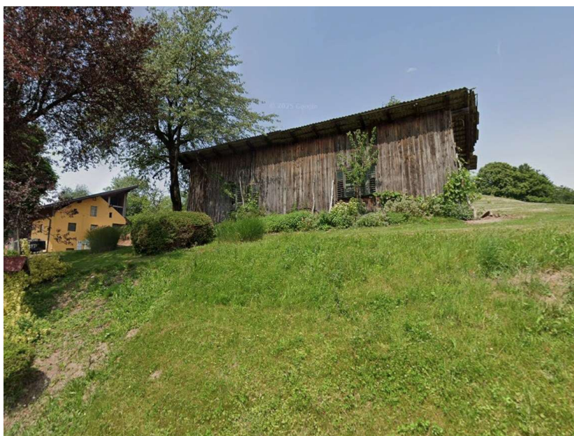
Slika 8: Objekt predviden za odstranitev, nadomesti ga nov stanovanjski objekt (vir: www.google.com/maps ).
