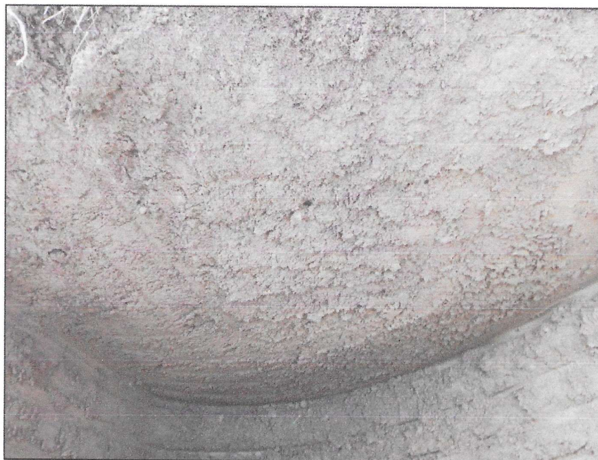
Slika 4: Spodnji sondažni izkop
