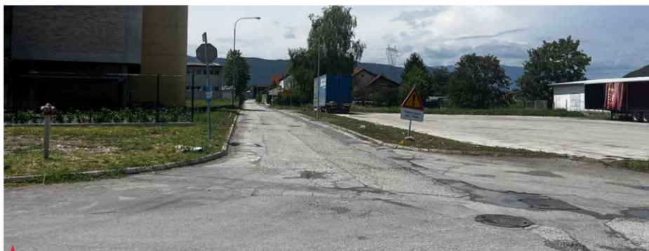
▲ Koncesijska pogodba prinaša dolgoročno ureditev rednega in zimskega vzdrževanja ter postopno obnovo občinskih cest v Občini Polzela.
