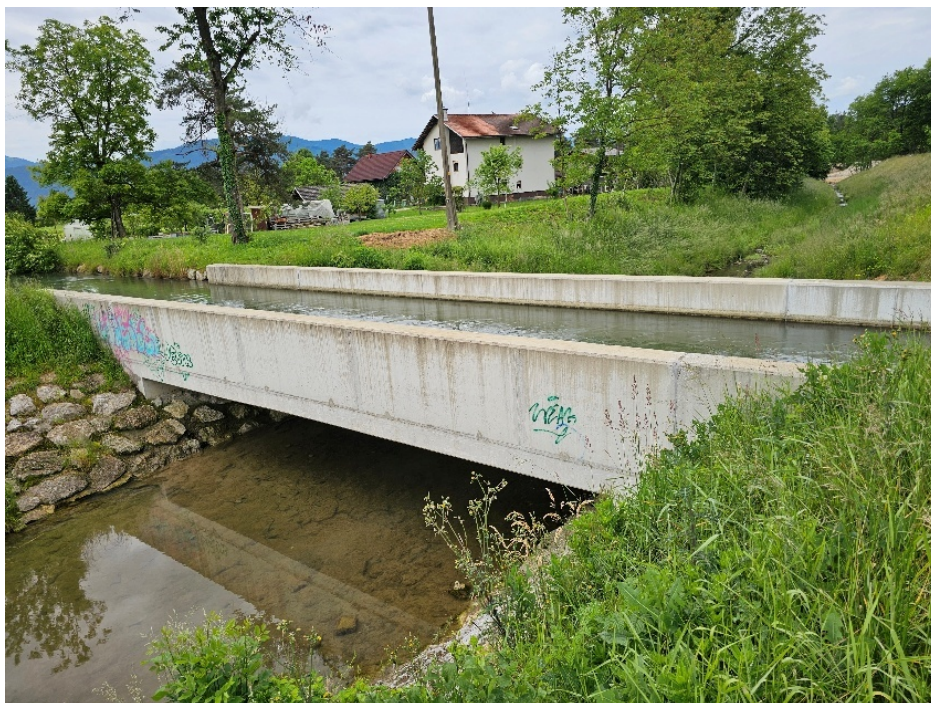
Slika 9: pogled na akvadukt spodaj poteka razbremenilni kanal Ložnice.
