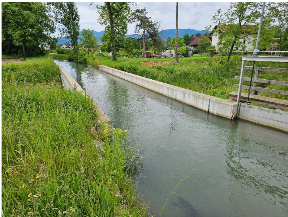
Slika 8: pogled na akvadukt Podvinske struge in zapornice – desno.
